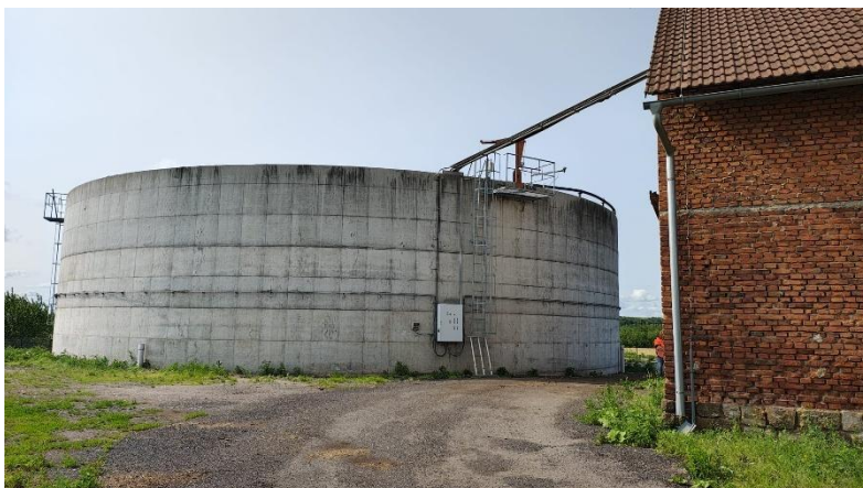
Obrázek: Pohled na skladovací nádrž
