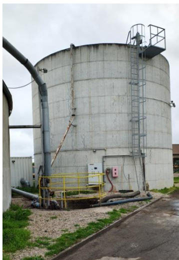
Obrázek: Stávající vstupní jímka
