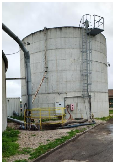
Obrázek: Stávající vstupní jímka
