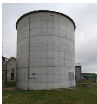
Obrázek – Objekt plynojemu
