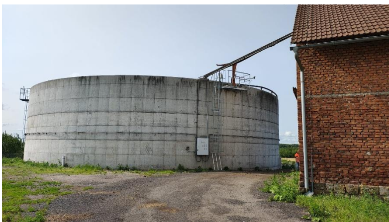
Obrázek: Pohled na skladovací nádrž
